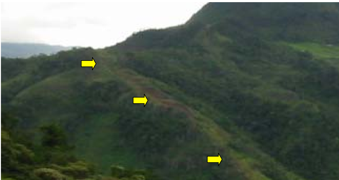
Foto No. 2 Oleoducto Caño Limón Coveñas a la altura de la Vereda Mesarica en dirección Oriente Occidente.
